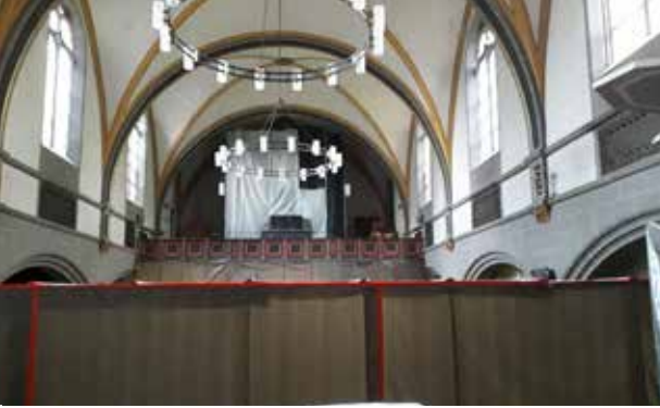
Alles gut eingepackt: Staubschutzmaßnahmen in der Christuskirche, hinten die eingebaute Orgel. – Foto: Hendrike Racky
