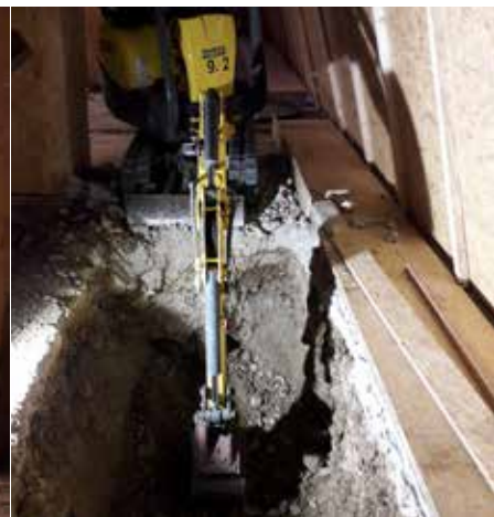
Hinter den Bankreihen: Mit Elektroantrieb werden die Gruben für die Wärmestationen ausgehoben. Foto: Hendrike Racky
